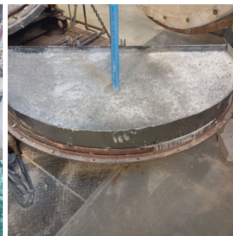
Coulée de béton réfractaire dans un coffrage de porte de chaudière
