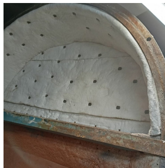
Laine céramique en couches, retenue par des tiges et rondelles
