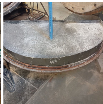
Réfection d'une zone en béton réfractaire
