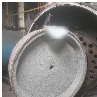
Porte doublée de béton réfractaire, après la coulée
