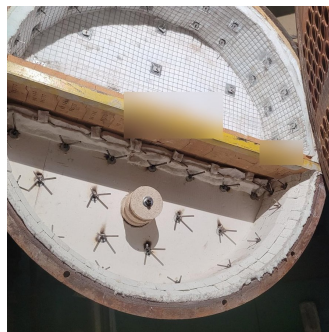
Porte arrière : laine ancrée, grillage et tuiles de déflecteur
