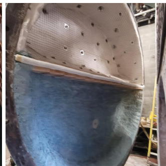
Porte arrière : laine en haut, béton réfractaire en bas
